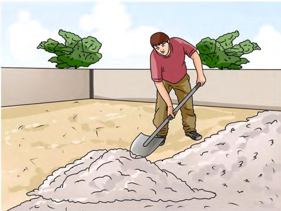
**5** Насыпьте гравий. Рекомендуется засыпать слой самоуплотняющегося гравия размером 5-6 мм. Крупный гравий (12 мм и более) не позволит сделать насыпь максимально ровной. Слой гравия должен быть на 6 мм выше гибкого бордюра с небольшим возвышением в средней части площадки. Для участка 6х6м рекомендуется поднять уровень средней части на 25 мм относительно краев. Так ваш газон будет иметь вид небольшого «холма». Дело в том, что плоские искусственные газоны выглядят очень неестественно!
