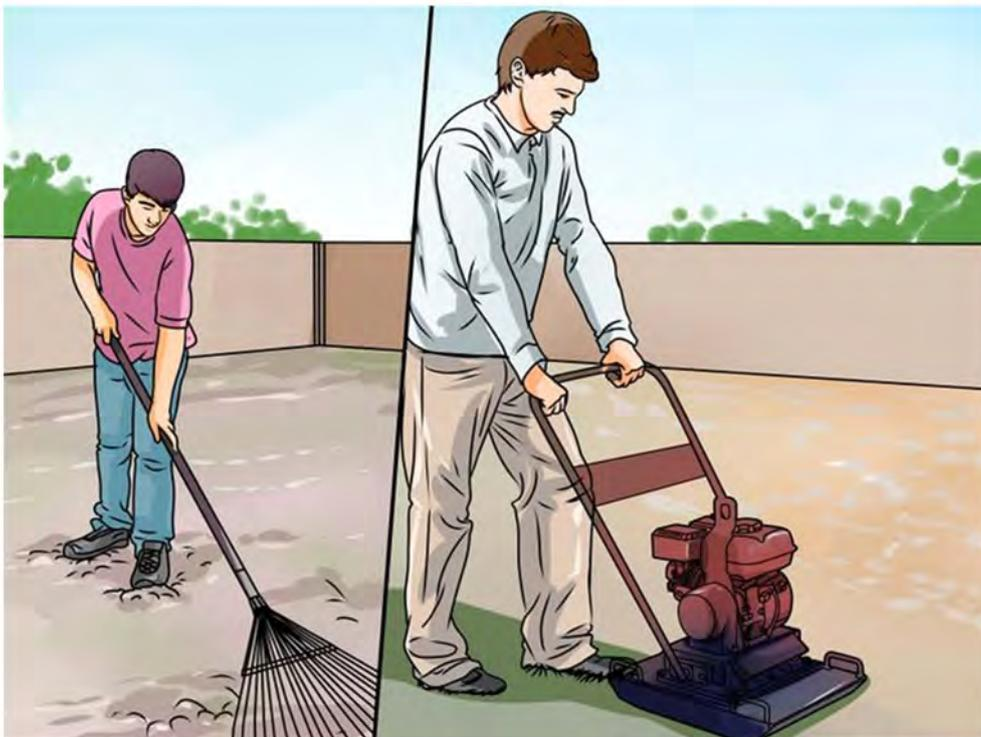
**6** Разравняйте и уплотните. Разравняйте большими алюминиевыми граблями. Такие грабли имеют зубцы с одной стороны и плоскую разравнивающую поверхность с другой. Распределите гравий максимально равномерно. Пролейте участок из шланга и уплотните с помощью виброплиты (также можно взять напрокат).
