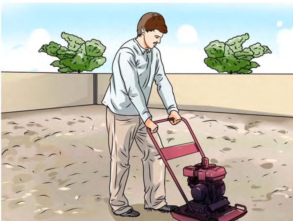
**8** Снова выполните уплотнение виброплитой. По краям останутся небольшие линии от кромки виброплиты. Разравняйте их плоской стороной граблей. Также устраните возвышения гравия по краю будущего газона (вдоль гибкого бордюра), чтобы газон не выглядел ненатурально. Можно воспользоваться жесткой метлой и смести лишний гравий.
